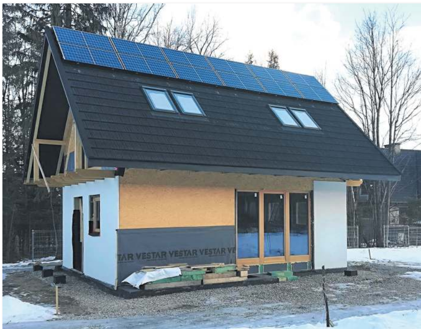
Fot. 3. W trakcie badania termowizyjnego potwierdzono bardzo dobrą ochronę cieplną ścian zewnętrznych. Niewielki udział strat ciepła odnotowano w miejscach połączenia profili stolarki okiennej i drzwiowej ze ścianami
